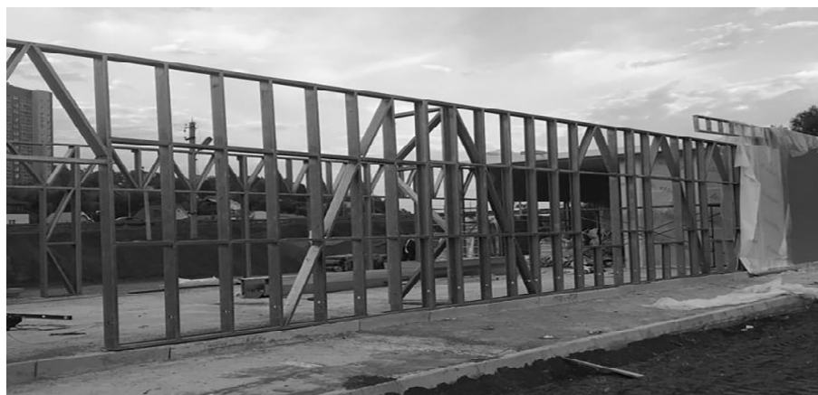
Рис. 5.14. Автосалон Уфа – Монтаж панелей стен на фундаментную плиту, длина здания 40 м
