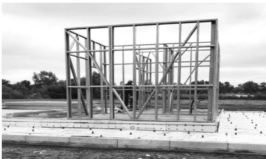
Рис. 5.13. Автосалон Уфа – Монтаж первых панелей стен на фундаментную плиту 08.09.2018 г.
