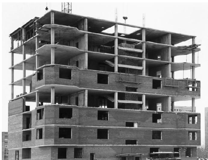
Рис. 3.6. Строительство жилого дома в городе Тольятти
