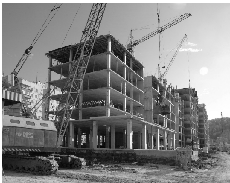
Рис. 2.2. Строительство жилого дома в г. Жигулёвск
