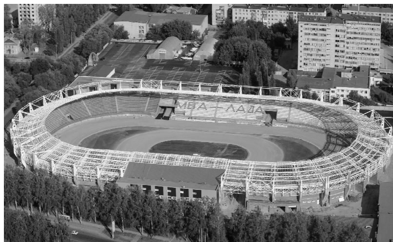
Рис. 4.5. Трековый стадион в г. Тольятти во время реконструкции
