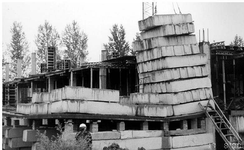
Рис. 3.3. Натурные испытания стыка железобетонной монолитной плиты с колонной
