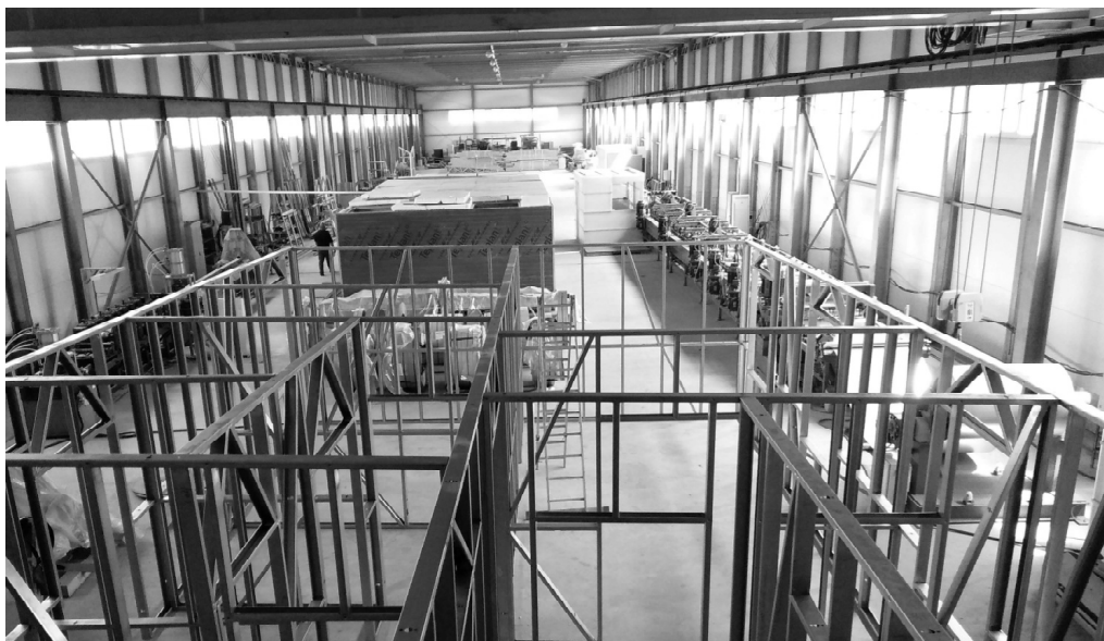
Рис. 5.5. Производственное здание. Вид внутри здания
