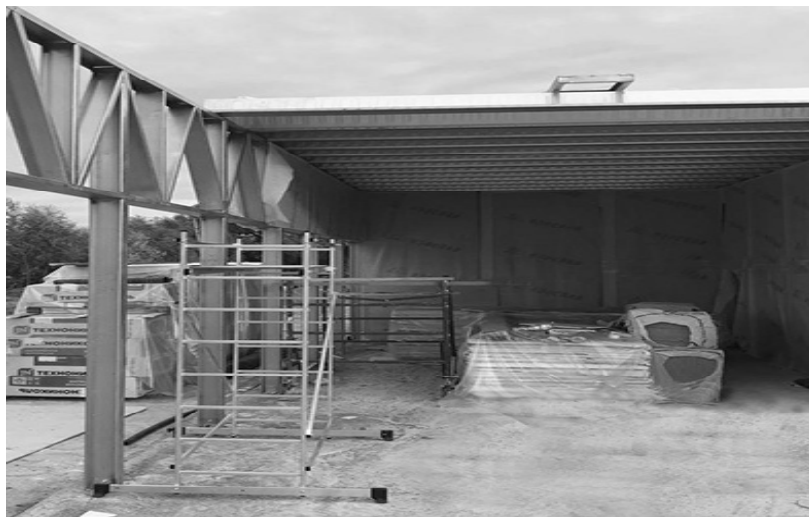
Рис. 5.15. Автосалон Уфа – Монтаж покрытия из профилей «БИЗОН», пролет здания 7,5 м
